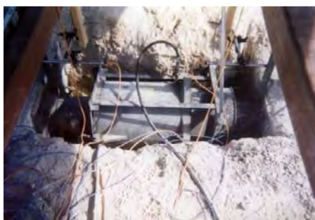
Konwencjonalne próbne obciążenia poziome (boczne)
