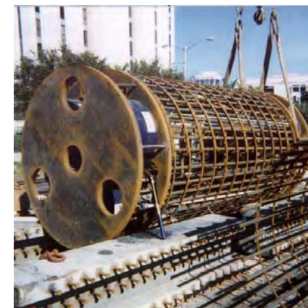
Badania o znacznym zakresie z zastosowaniem systemu kilku komór Osterberga
