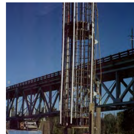
Instalowanie komory Osterberga na wielu poziomach
