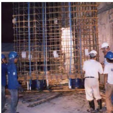
Instalowanie komory Osterberga w bariacie wypełnionej zawieszoną tiktotropową
