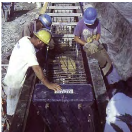
Instalowanie komory Osterberga w palach prefabrykowanych
