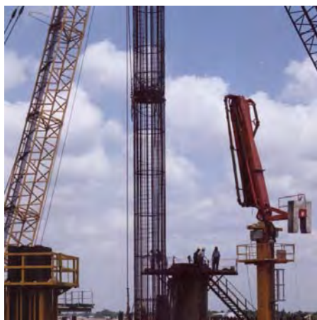
Pomyślne zainstalowanie zbrojenia pali o długościach od 4.5 do 107 m. Prefabrykowane pale o długości do 40 m zostały wite i zbadane za pomocą komory Osterberga
