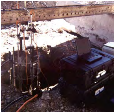
Przygotowanie komory Osterberga do wykonania badania
