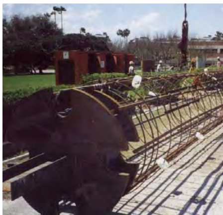
Komora Osterberga gotowa do zainstalowania na jednym poziomie.
